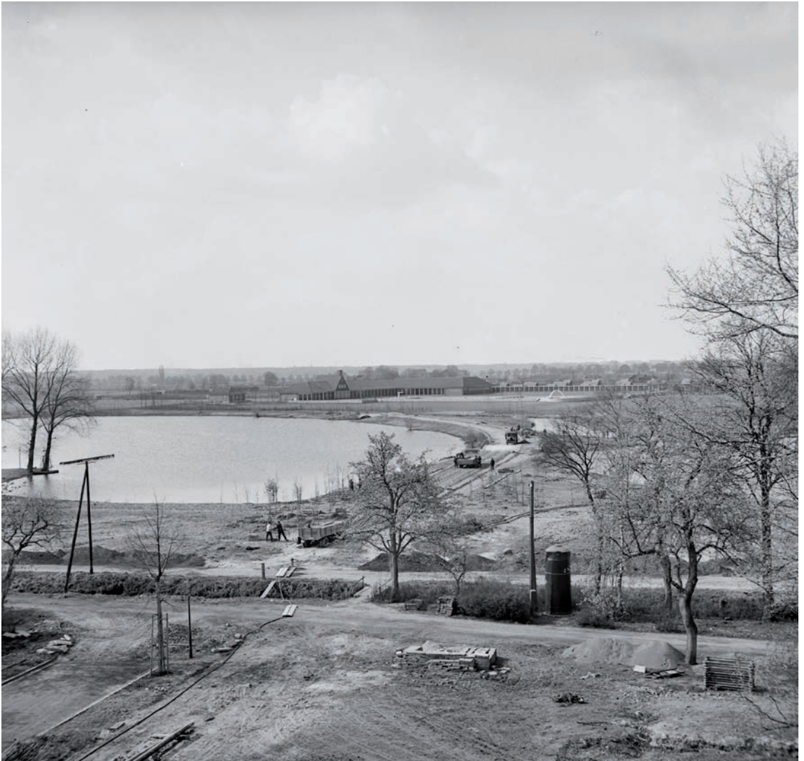
Abb. 3: Bauarbeiten im Hermann-Löns-Park, um 1936, © Historisches Museum Hannover
