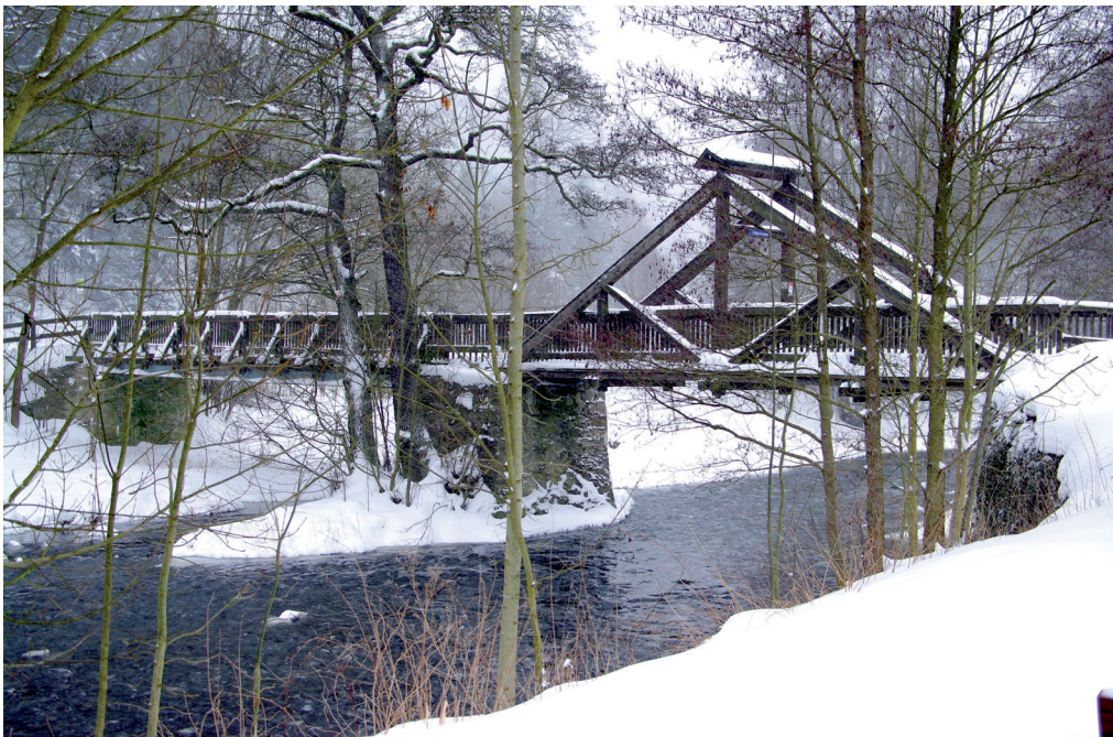
Selbitzbrücke bei Blankenstein (Foto: Ansgar Hoppe)
