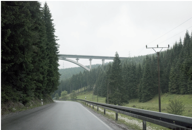
Abb. 6: Die Massetalbrücke im Thüringer Wald (Foto Andreas Bartholl)
