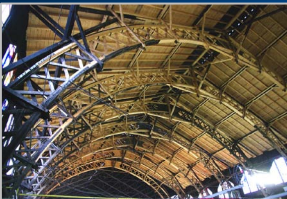
Dachkonstruktion Glaserei Lamberts
