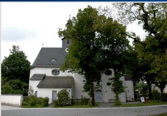
Die Kirche in Issigau (Außenansicht)
