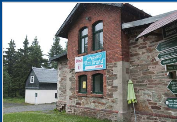
Gasthaus Brand am Rennsteig
