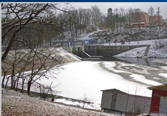
Die Talsperre Skalka (Tschechien) mit Stauwehr
